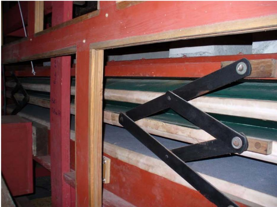
**Réservoir gonflé : on distingue le parallélogramme servant à maintenir la table supérieure avec le lest (plaques de béton) au dessus.**
